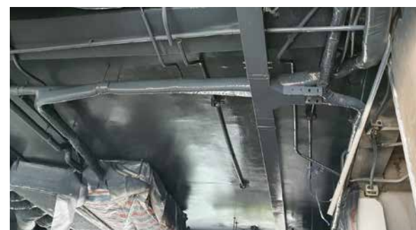
DỰ ÁN: CÔNG TRÌNH LẮP ĐẶT HỆ THỐNG ĐIỀU HÒA KHÔNG KHÍ NGÂN HÀNG ĐÔNG Á
