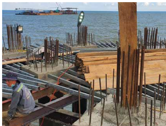
DỰ ÁN: CÔNG TRÌNH XÂY DỰNG TRỤ MÓNG ĐƯỜNG ĐIỆN 220KV PHÚ QUỐC
